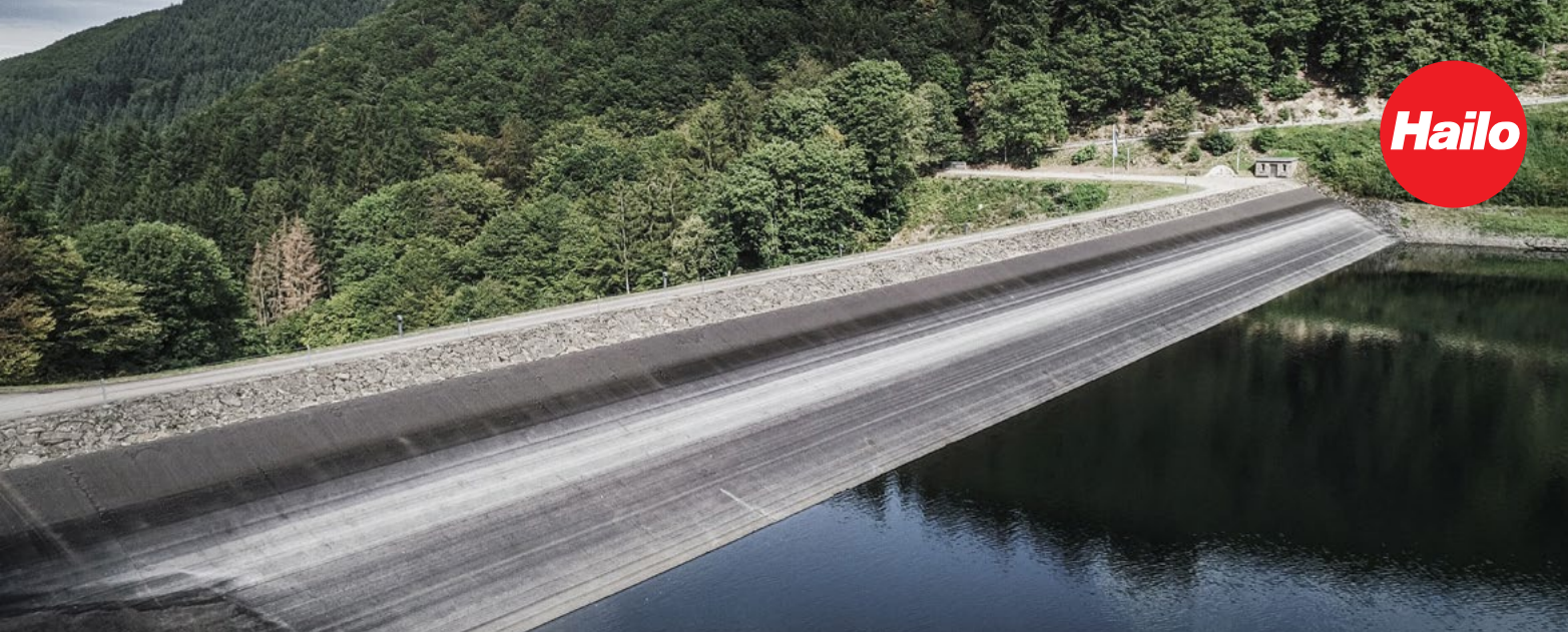
Talsperre (Trier), GLOBALift im Schieberschacht, 50 m tief
